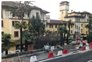
Sono iniziati i lavori di restyling della zona nobile di Gardone Riviera
