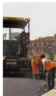
Lavori di asfaltatura
